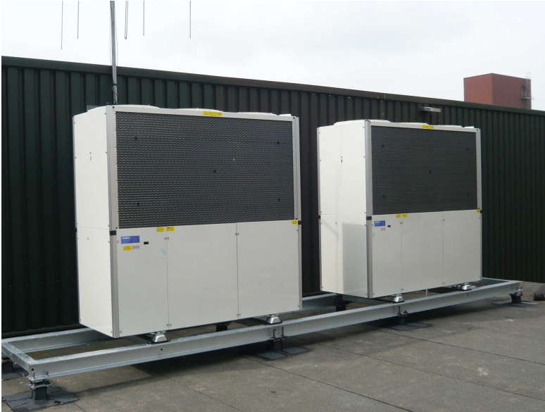
Voorbeeld opstellingsframe boven staaldak i.c.m. extra trillingsdempers
